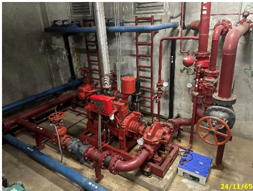
เครื่องสูบน้ำสำหรับเพื่อดับเพลิง
